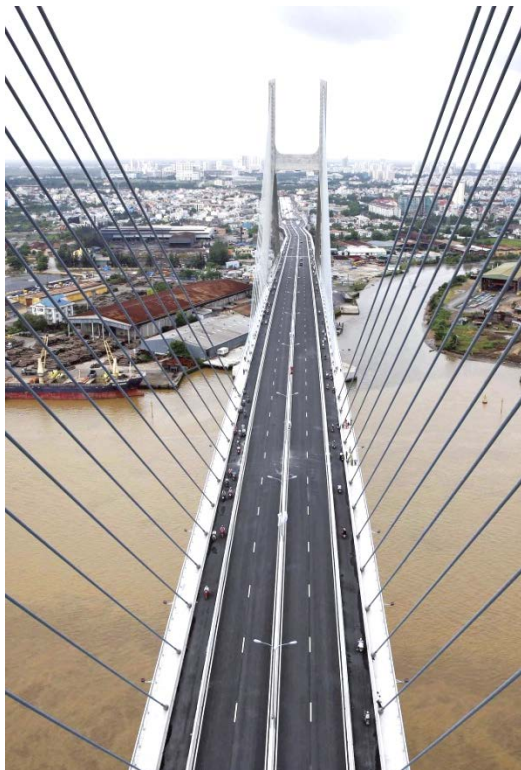
Cầu Phú Mỹ - Cầu dây cáp dài nhất Tp. HCM
